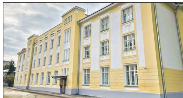
В лечебном корпусе №2 основные работы уже закончили
