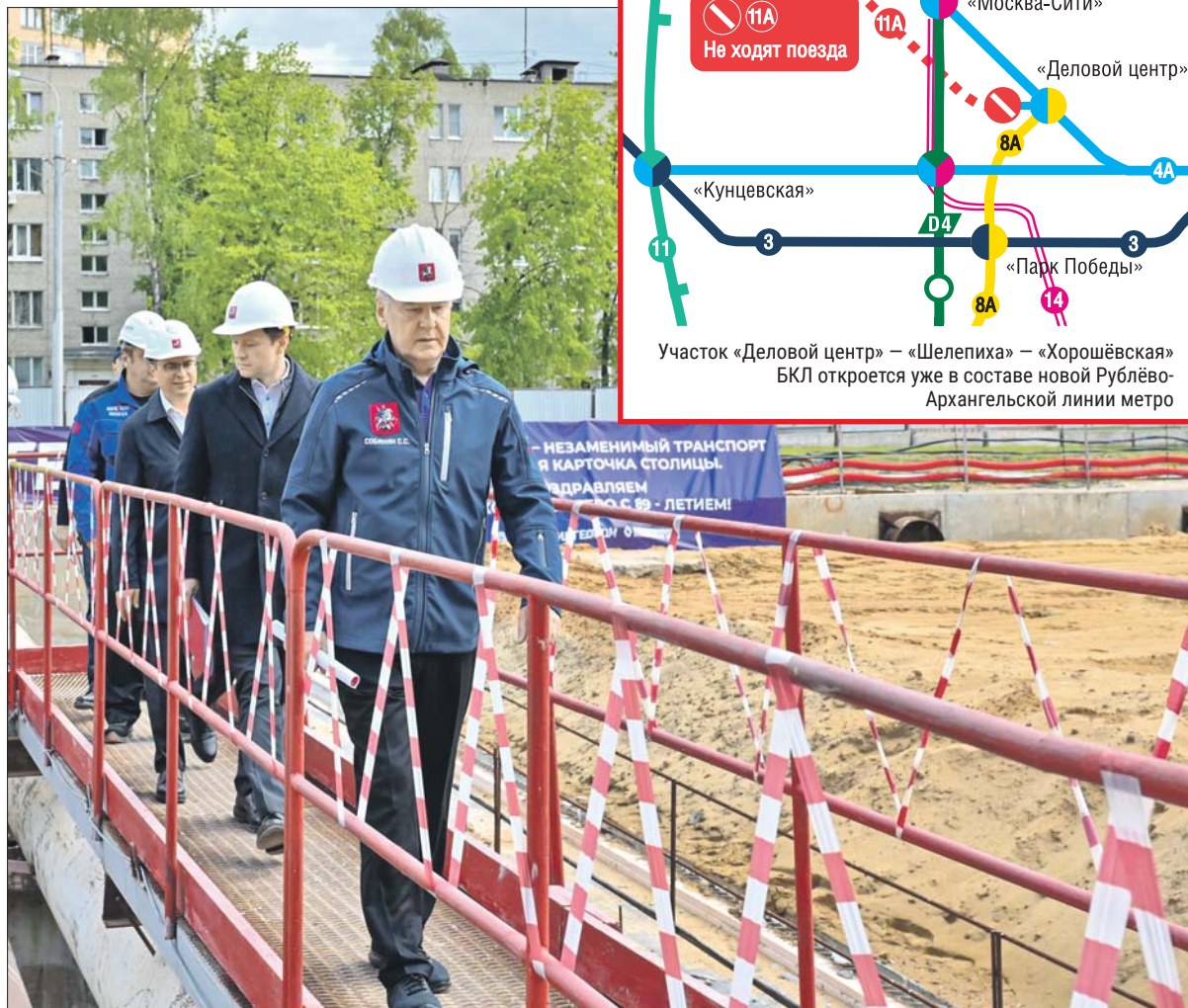
В мае этого года мэр дал старт проходке тоннелей между станциями «Народное Ополчение» и «Бульвар Генерала Карбышева»
