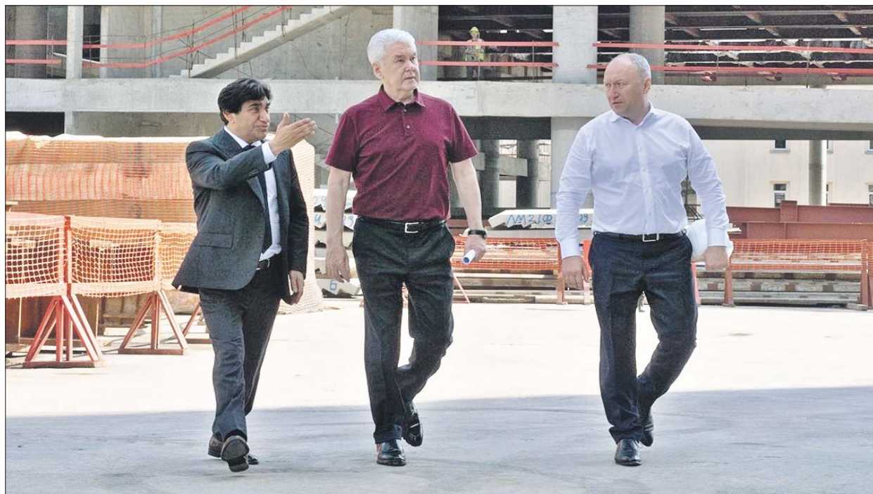
Мэр во время осмотра стройплощадки «Олимпийского». Август 2023 года
