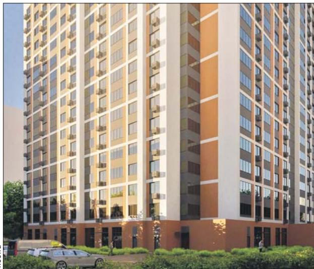
Фасад облицуют керамогранитом, кирпичом и архитектурным бетоном
