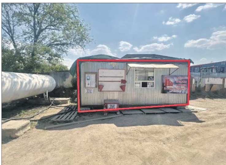
Нелегальная АГЗС работала во дворах автомастерских на Лихоборской набережной
