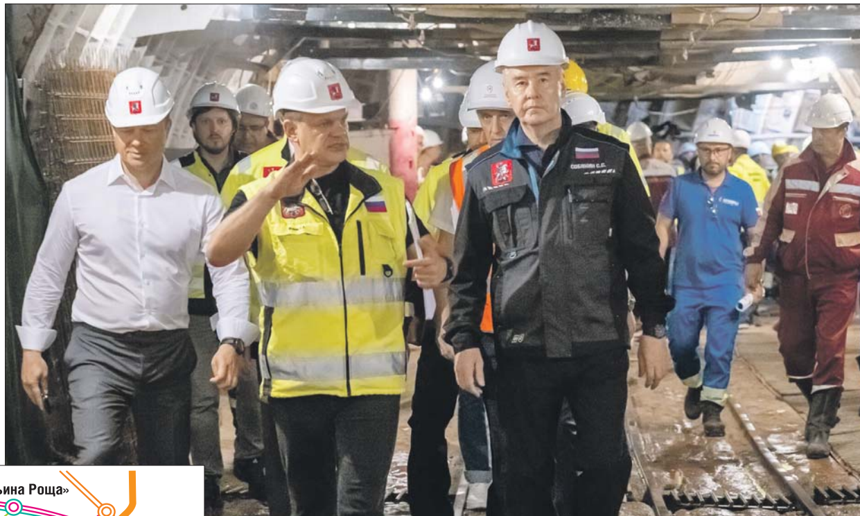
Начало работ по строительству новой станции осмотрел Сергей Собянин
