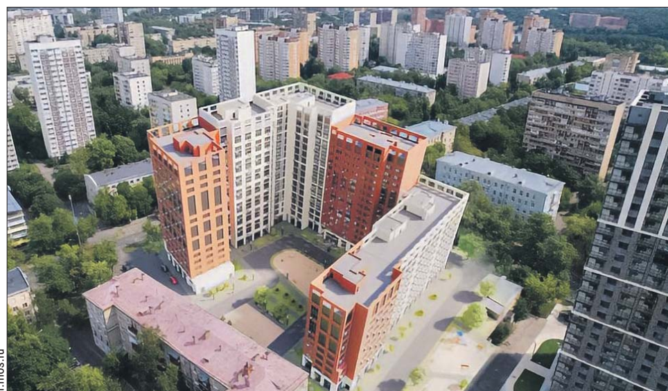
В новостройке будет семь подъездов
