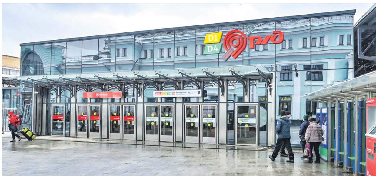
В новом пассажирском вестибюле 17 турникетов
