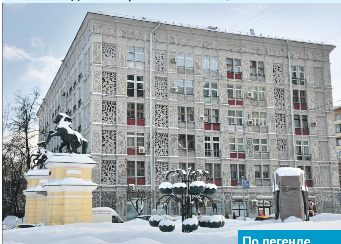
Ажурным дом называют из-за тонкой вязи каменного узора на фасаде
