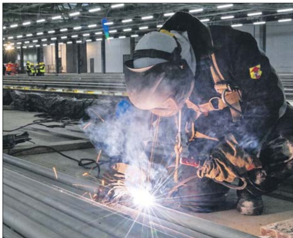
Строительство электродепо «Южное» близится к завершению
