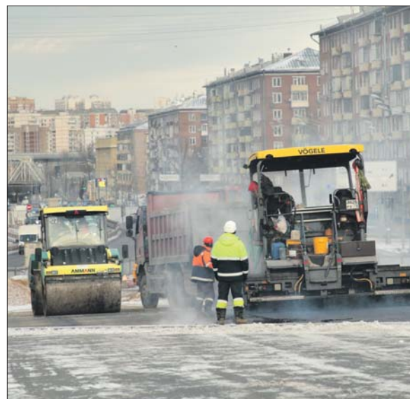
Сейчас работы завершены на три четверти
