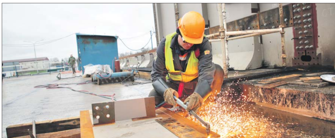
Сейчас ведётся сборка металлоконструкций будущего моста
