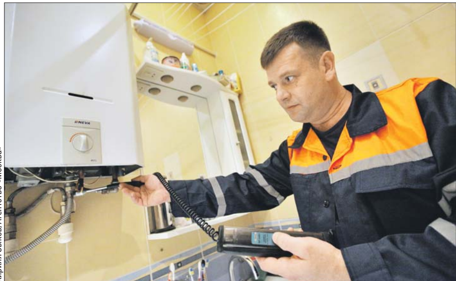
Если жителю пришло уведомление о нарушениях в установке газового оборудования, нужно вызвать газовщиков
