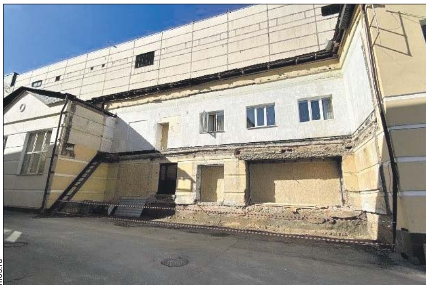
Владельцы здания сами демонтировали пристройку
