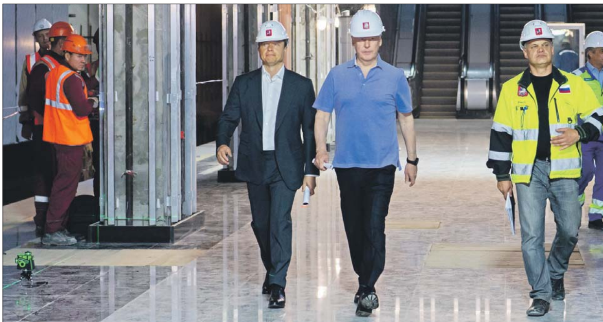
По словам мэра, на всех трёх строящихся станциях активно ведутся работы
