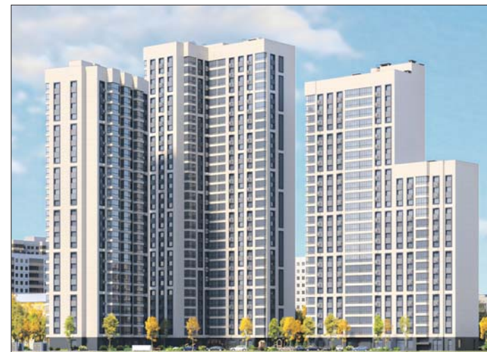
Здания образуют внутренний двор, закрытый для проезда машин
