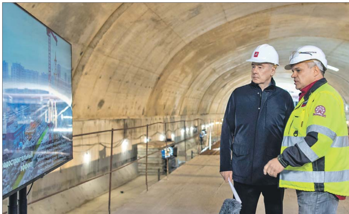
Сергей Собянин посетил строящуюся станцию «Яхромская»
