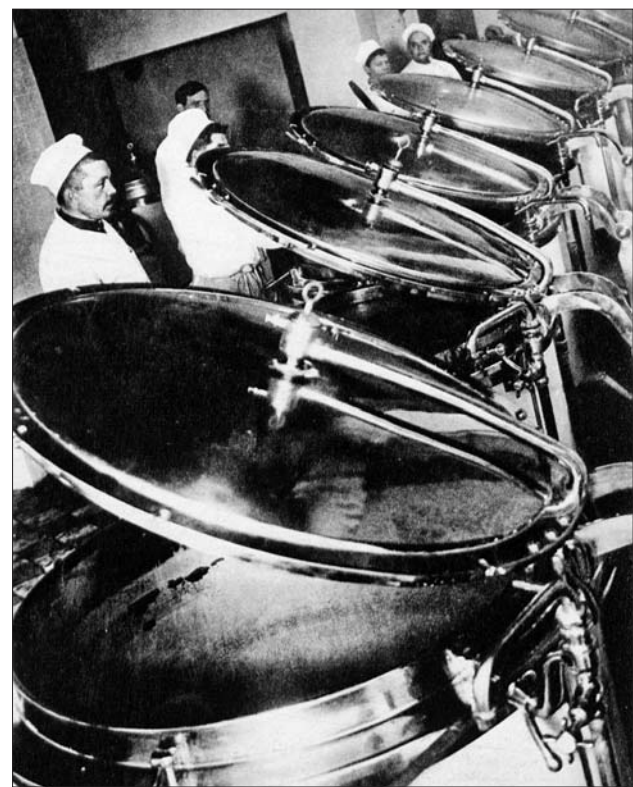
На фабрике-кухне было самое современное оборудование
