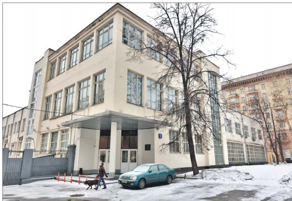
Здание 1929 года постройки сохранилось до наших дней
