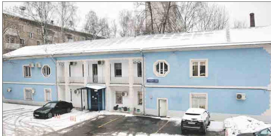
Площадь здания после реконструкции увеличится
