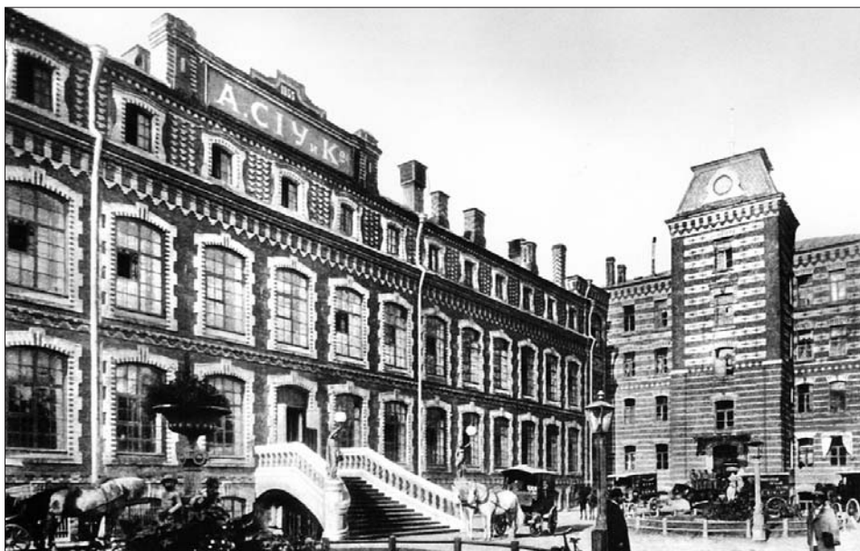
Первые фабричные корпуса на Петербургском шоссе были построены в конце XIX века
