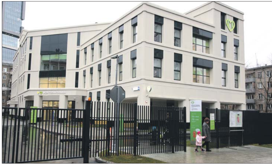
Детская поликлиника в Войковском получила новое здание и новое оборудование
