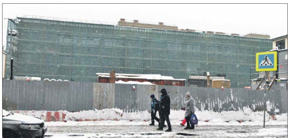
Сейчас идут отделочные работы и монтаж инженерных систем
