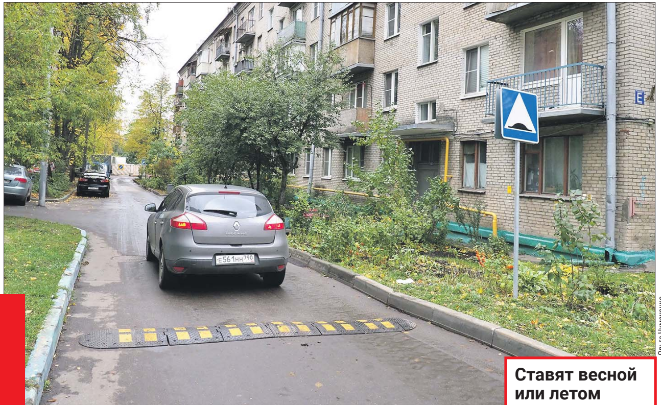
У дома 8 на Икшинской улице недавно установили искусственные неровности
