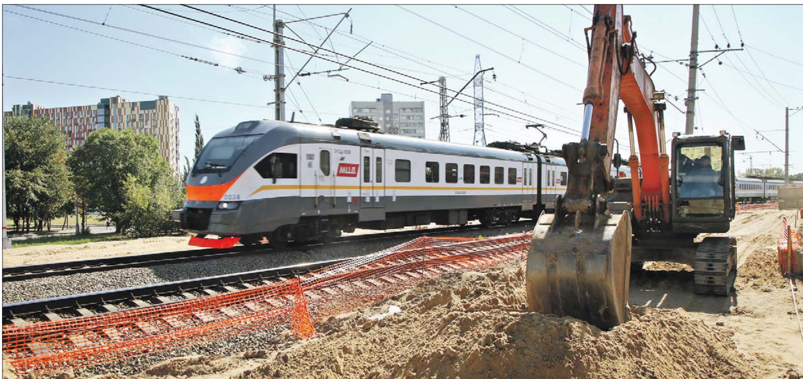
Рядом с существующими путями уложат новые, а старые потом демонтируют
