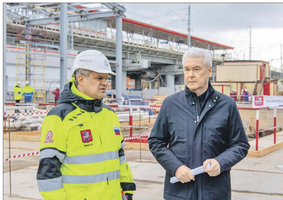
Мэр Москвы Сергей Собянин на строительстве северного вестибюля станции метро «Окружная», которую соединят со станциями МЦД и МЦК. Работы планируют закончить уже в этом году
