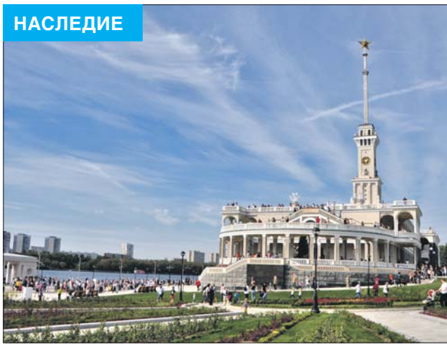
Здание восстанавливали по историческим документам
