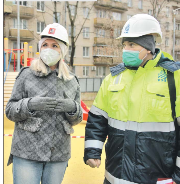
Ирина Белых посетила стройплощадку на Флотской
