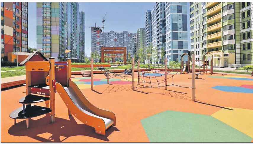
В части промзоны «Коровино» на Базовской улице уже возведён жилой квартал
