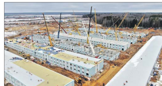
Работа на стройплощадке ведётся круглосуточно
