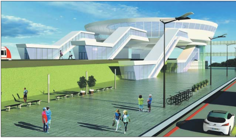
На «Петровско-Разумовской» ТПУ объединит электрички и метро
