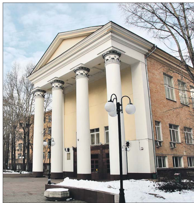
ТЭИ размещался в здании на Часовой улице, 22/2
