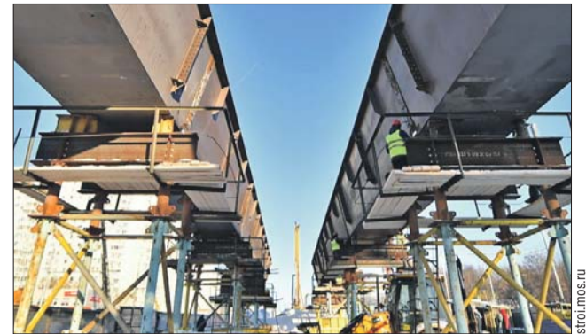
Завершён монтаж металлоконструкций пролётных строений путепровода
