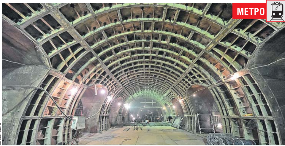
Поезда будут следовать мимо строящейся «Беломорской» к «Ховрино»
