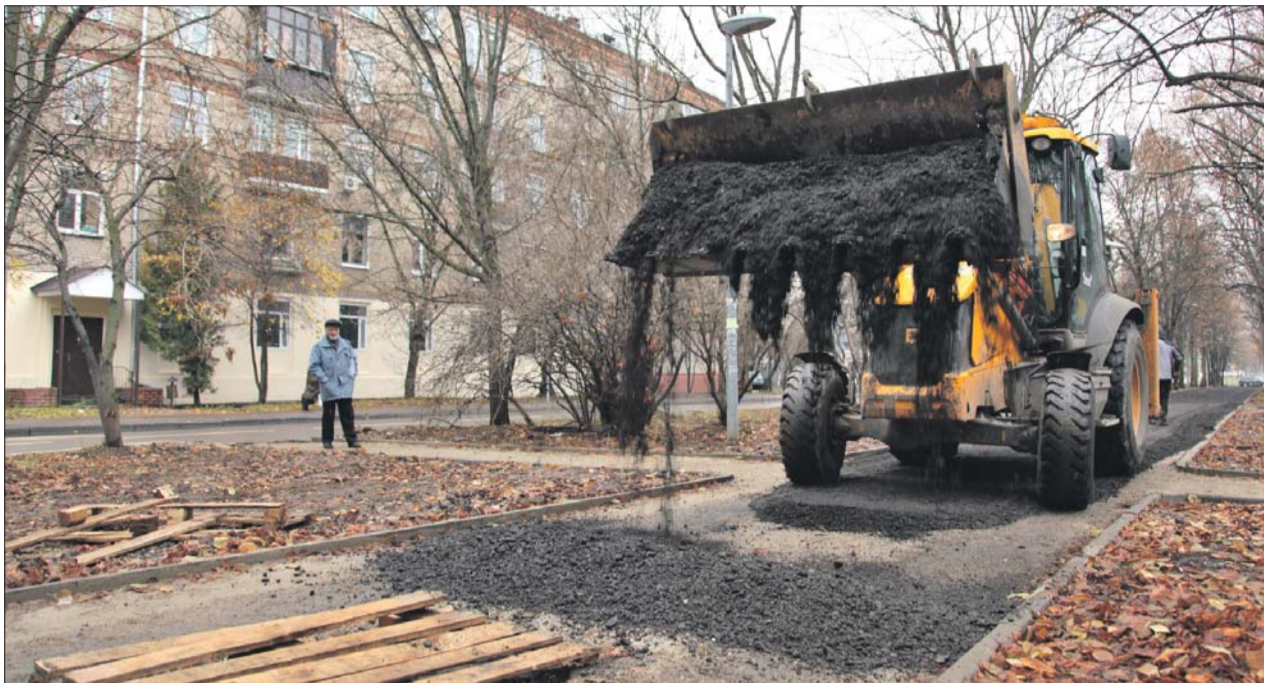
Сейчас работы на бульваре выполнены примерно на треть
