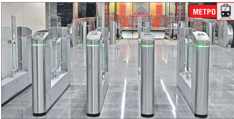
Сейчас завершается отделка новых станций
