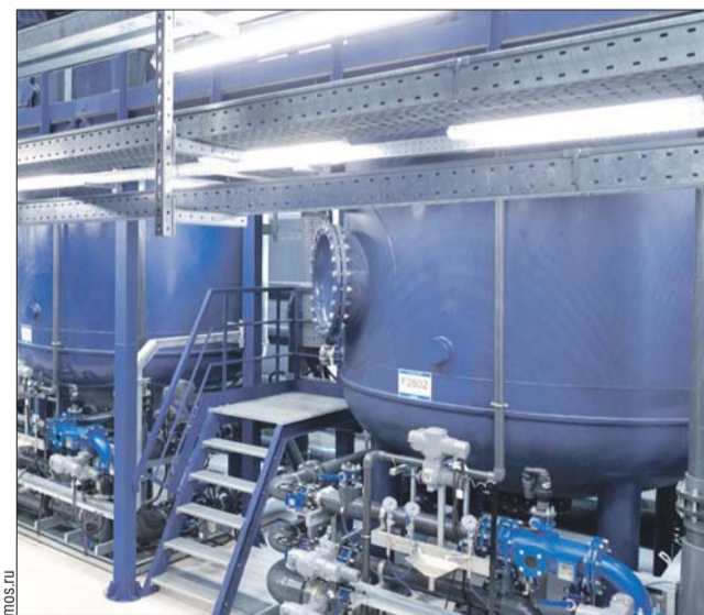
На МНПЗ установлены новые очистные сооружения
