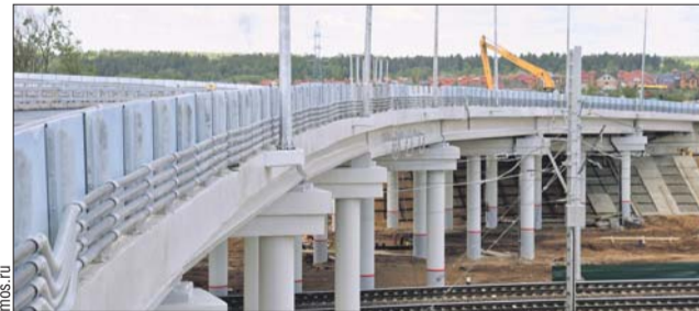
При реконструкции путепровода заменят балки пролётных строений и стойки опор
