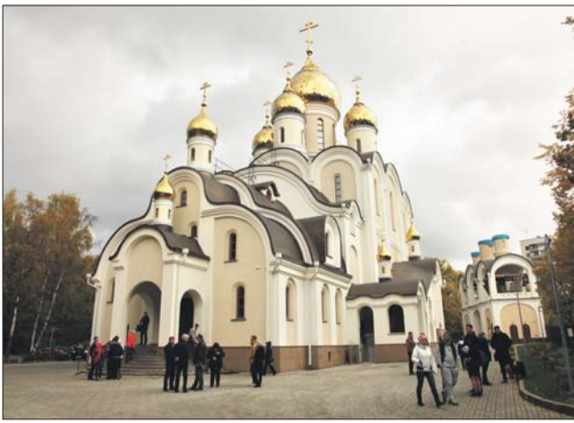
Наружные работы в храме Блаженной Матроны Московской завершены
