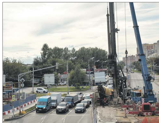
Сейчас идёт монтаж путепровода над Большой Академической улицей
