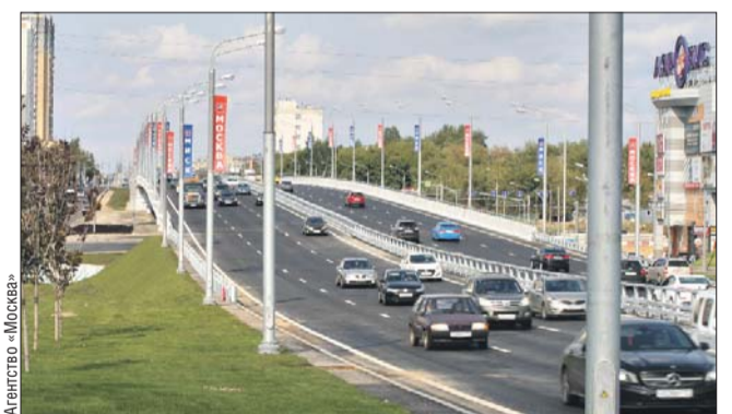
Новая эстакада соединяет Балаклавский и Пролетарский проспекты
