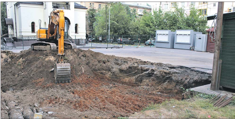
Сейчас ведутся подготовительные работы по закладке фундамента приходского дома
