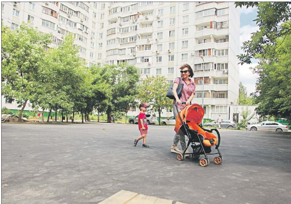
Будущую площадку уже заасфальтировали для укладки резинового покрытия
