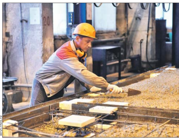
Девять ДСК уже перешли к строительству домов новых серий в Москве
