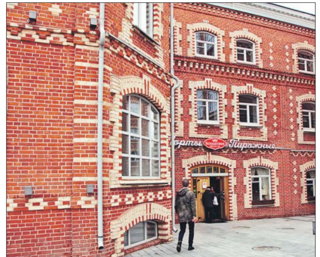
Реставраторы восстановили кирпичную кладку, узор которой напоминает рисунок на печенье
