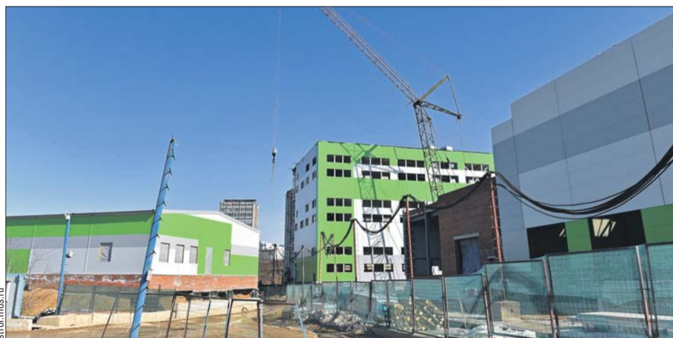
Основные объекты депо возведены, идут монтаж инженерных систем и подготовка под чистовую отделку
