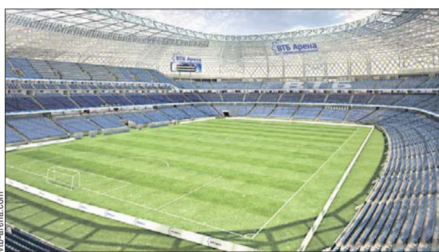
В конце весны на стадионе приступят к укладке газона
