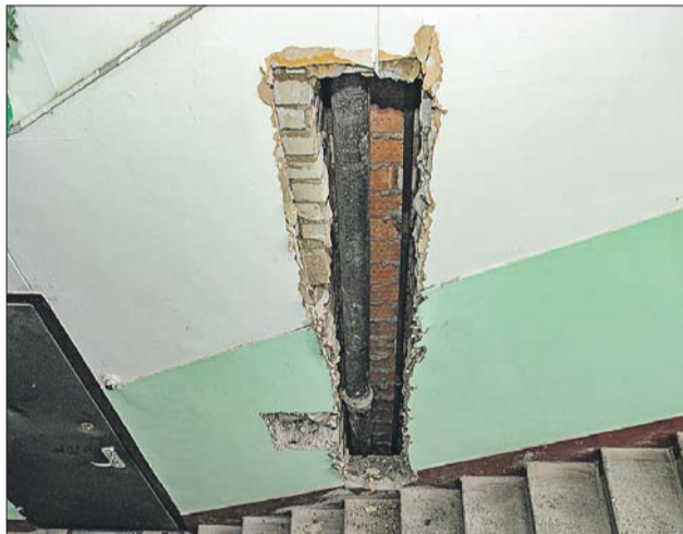
В доме на улице Гамалеи (СЗАО) стояки систем водоснабжения и канализации проложены в кладке внутренних стен
