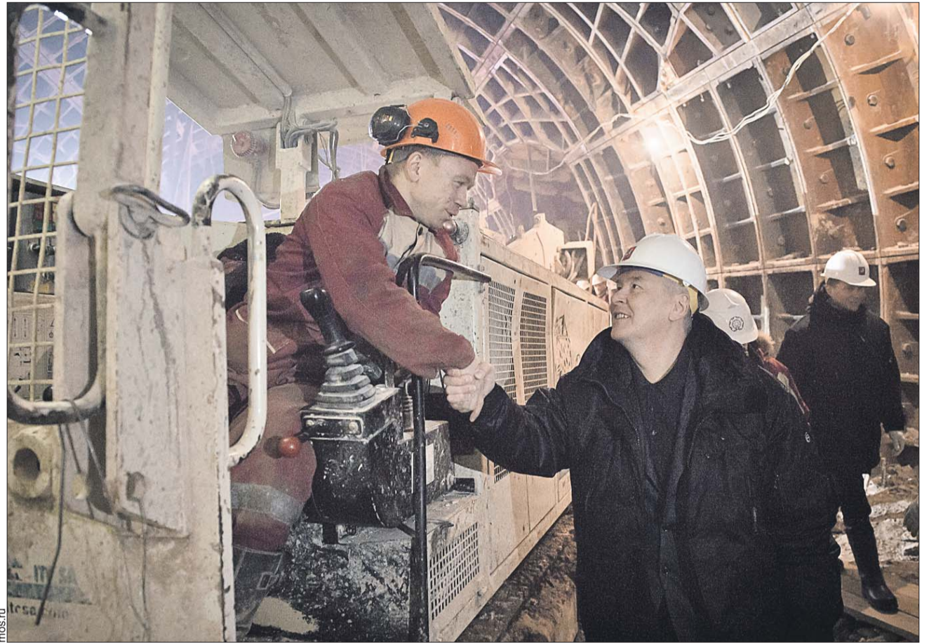
Строительство «Нижней Масловки» идёт на глубине 65 метров закрытым способом
